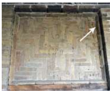
تصویر ۱۰: نمونه‌ای از آجر لب‌پخ (زمرشیدی، ۱۳۸۶: ۱۲۷) و کاربرد آن در حاشیه قاب تزیینی (نگارنده، ۱۴۰۱)
