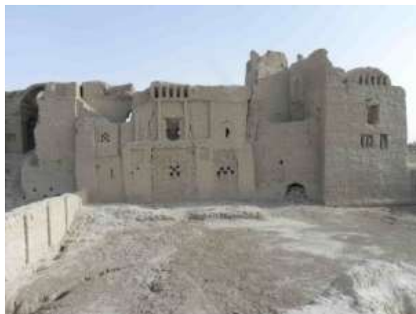
تصویر ۱۰. نمای شمالی ارگ ورمال. انواع بادگیرها، پنجره‌ها و روزنه‌های تهویه هوا (نگارندگان)
