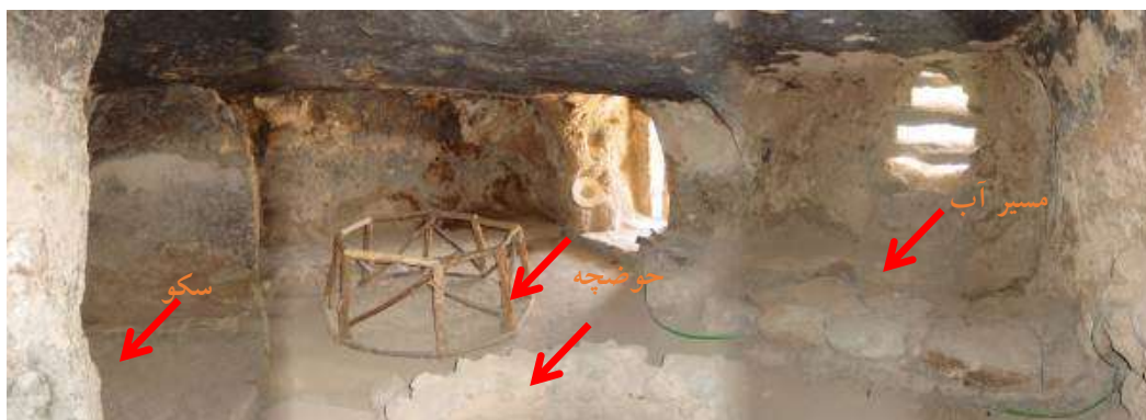
تصویر ۲۳: نمایی از داخل حمام میمند که در آن مسیر جریان آب و حوضچه‌های شستشو و سکوها با فلش مشخص شده است (نگارندگان)
