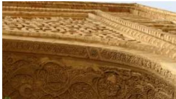
تصویر ۱۲- تصویر نمای طاق سردر در ایوان انتهایی رباط شرف. منبع: نگارندگان
